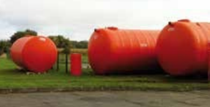
Homogénéisateur 80 m3 avec éjecteur d'air, décanteur primaire, réacteur biologique, clarificateur et silo de stockage des boues, pour le traitement des effluents qui proviennent d'une usine de récupération (lavage) des plumes de canard
