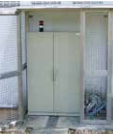
Abri préfabriqué qui protège de l'extérieur le coffret et le compresseur
